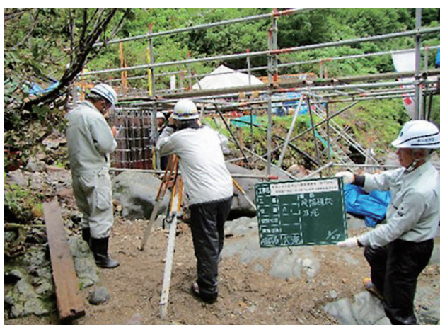
工事現場監督 (橋梁上下部工 基準高検査)
