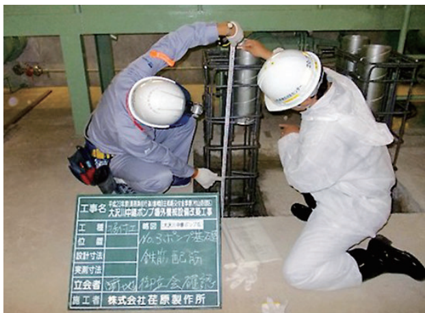
工事現場監督(ポンプ場基礎配筋確認)
