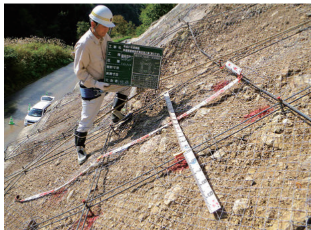
工事現場監督(法面砕出来形確認)
