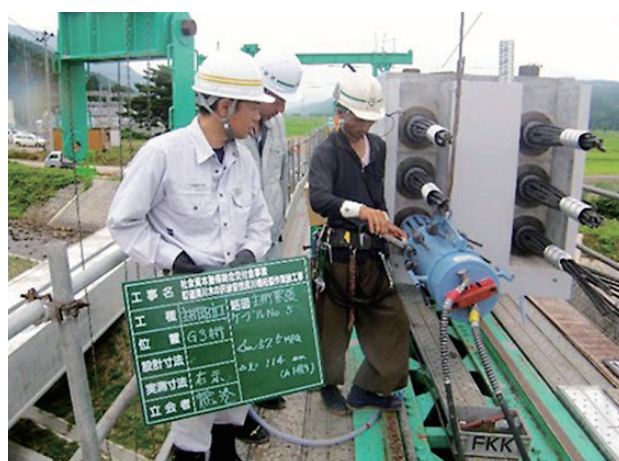
工事現場監督 (橋梁上部 ケーブル緊張確認)
