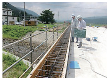
市町村の橋梁補修工事
