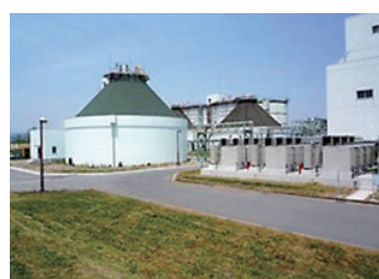
消化ガス発電
