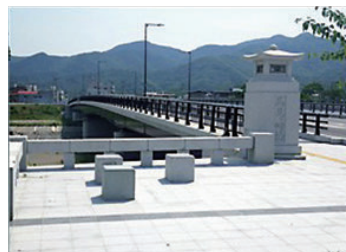
馬見ヶ崎橋橋梁架設
