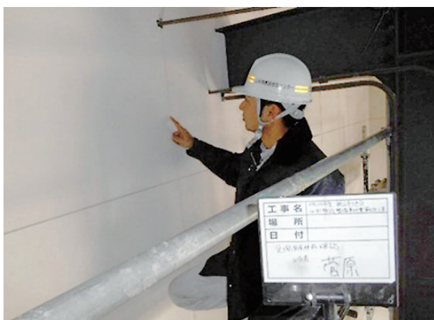
工事監理(揚水機場外壁検査)
