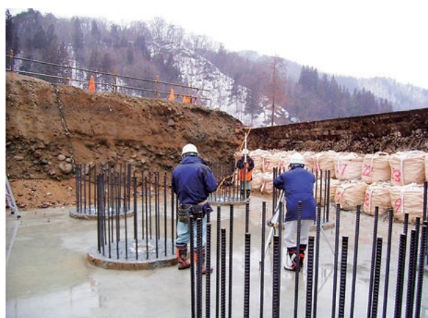
工事現場監督 (橋梁下部工 基準高検査)
