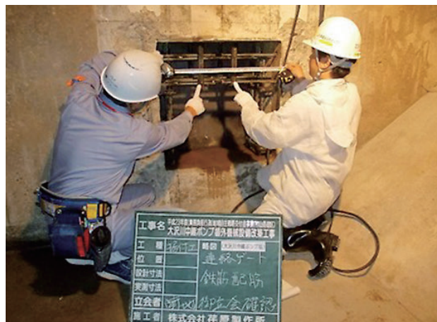
工事現場監督(ポンプ場ゲート寸法確認)
