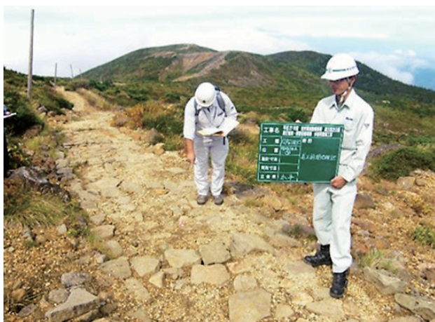
工事現場監督(自然歩道出来形確認)
