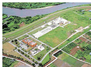
村山浄化センター
