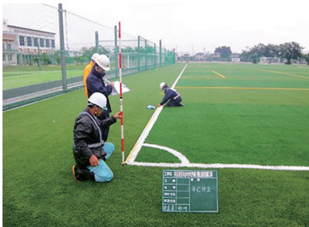
工事現場監督(グラウンド出来形検査)
