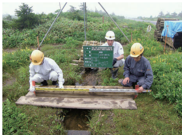
工事現場監督(自然歩道出来形確認)
