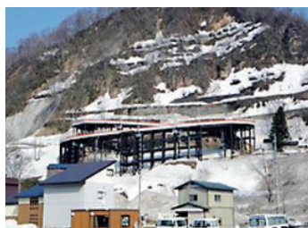
(主)戸沢大蔵線道路災害復旧
