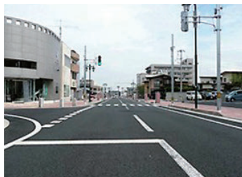
新築西通り二口橋線 道路改良
