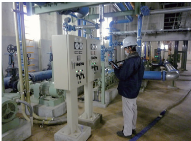
下水道施設維持管理
