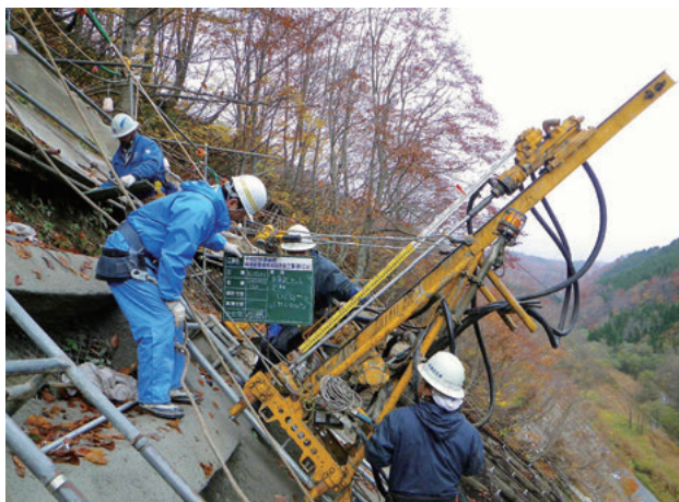
工事現場監督(法面アンカー強度確認)
