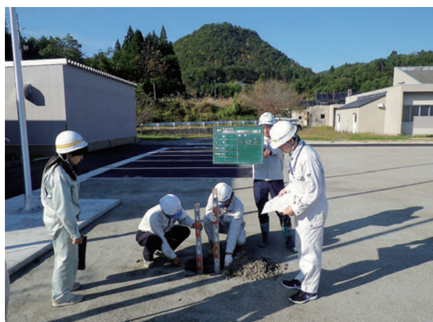
工事現場監督(外構路盤厚検査)
