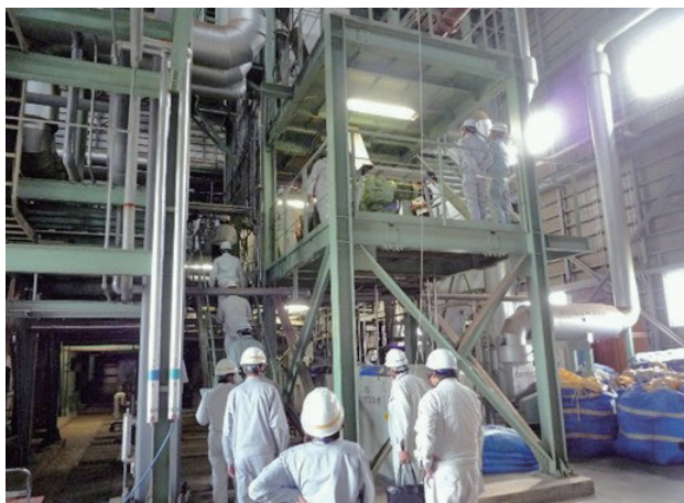
下水道施設維持管理現場研修
