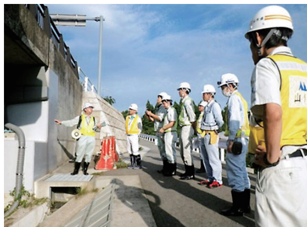
道路メンテナンス研修(橋梁)
