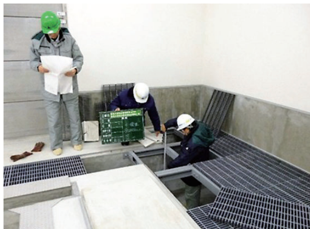
工事監理(簡易水道施設検査立会)
