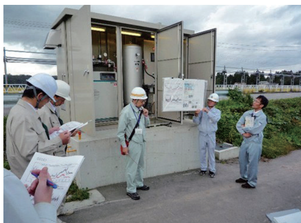
下水道施設維持管理現場研修
