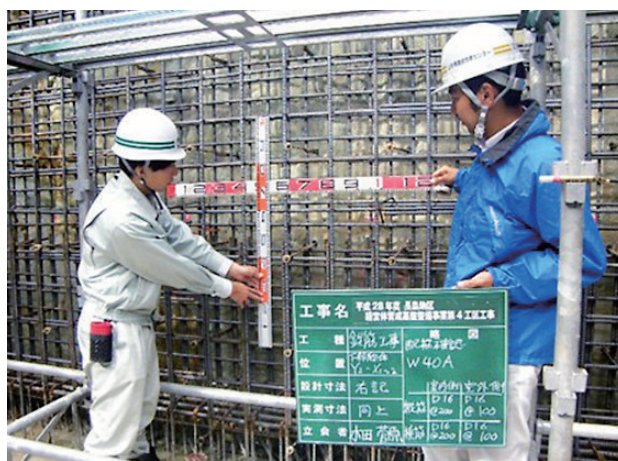
工事監理(揚水機場検査立会)
