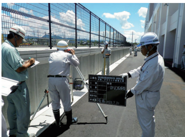
工事現場監督(外構基準高検査)
