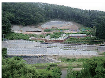
一般国道287号 道路災害復旧
