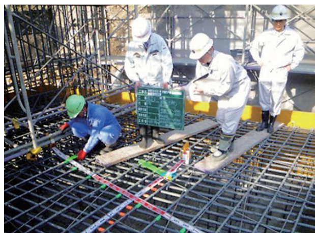
工事現場監督 (橋梁下部工 配筋検査)
