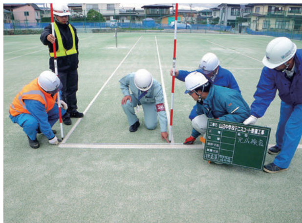
工事現場監督(テニスコート出来形検査)
