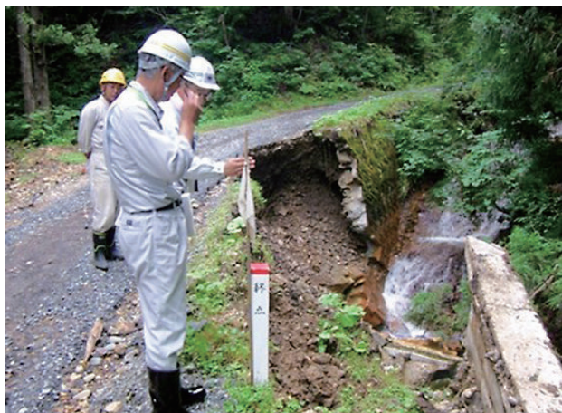
災害復旧初期支援(河川) (南陽市)
