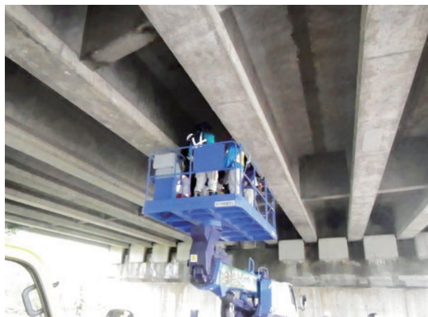
道路メンテナンス研修(橋梁)
