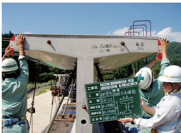
工事現場監督 (橋梁上部工 出来形検査)
