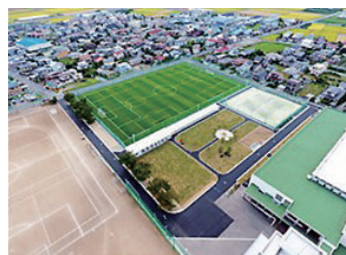
中山中学校外構・運動施設整備
