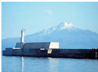
飛島漁港南防波堤ケーソン据付
