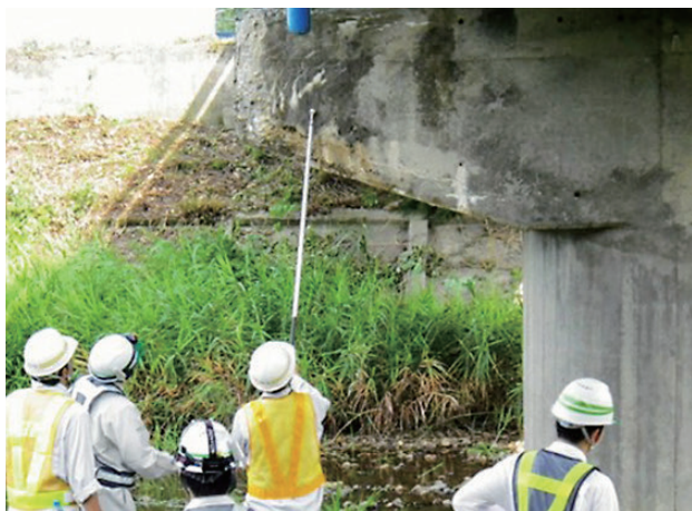
道路メンテナンス研修(橋梁)
