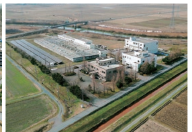
④ 庄内浄化センター
